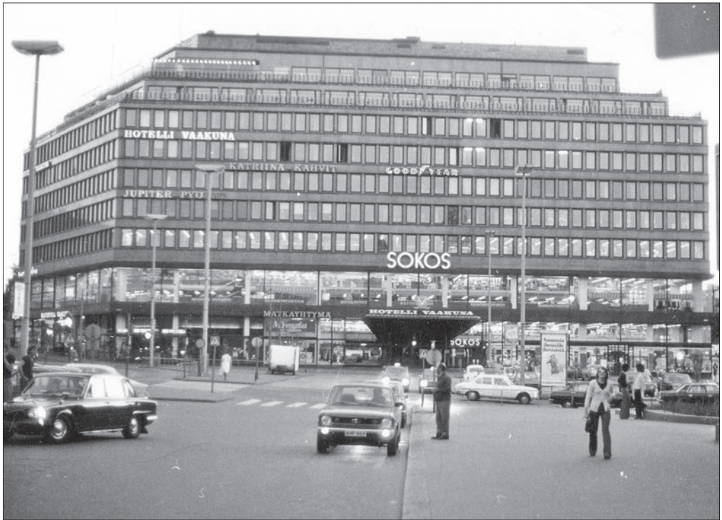
Helsinki, Hotel Vaakuna, 1977.
